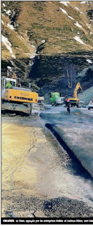
CHANTIER. La Stam, appuyée par les entreprises Vialleix et Lachaux Béton, vient livrer à 1.800 mètres d'altitude entre la France et Andorre afin de ouvrir la route RN 22, seul axe menant au Pas de la Case.
